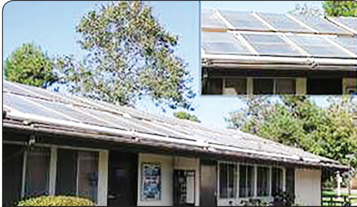
نمایی از خورشیدی کردن سقف کارگاهی در اروپا
