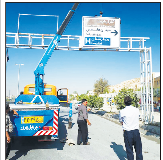
باز سازی و نوسازی تابلوی جهت نما در ورودی شهر فلکه سنگی توسط واحد خدمات شهری کازرون
