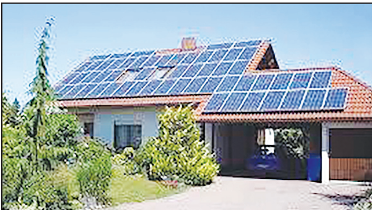
نوع دیگری از نصب پنل‌های خورشیدی روی سقف خانه در جهت جنوب
