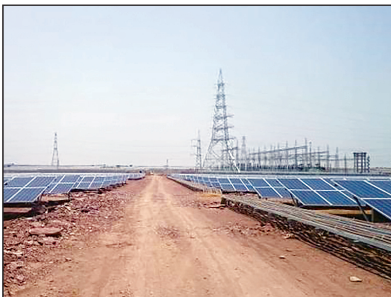
این پارک خورشیدی در شهر Kurnool در مناطق جنوبی هند احداث شده است. ظرفیت تولید برق در این پارک خورشیدی ۱۰۰۰ مگاوات تعریف شده؛ اما در حال حاضر ۹۰۰ مگاوات در مدار بهره‌برداری است.
