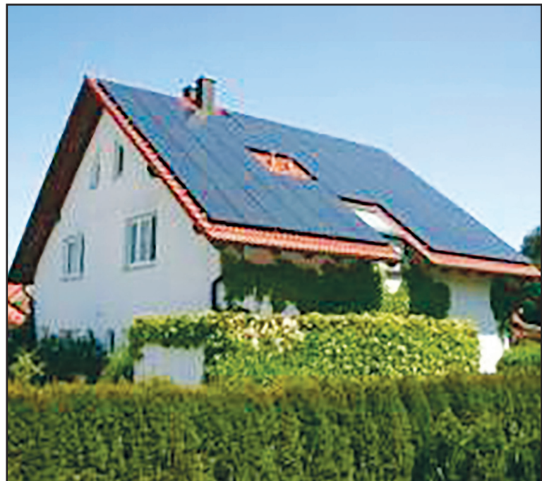
پنل‌ها روی سقف این خانه به‌صورت زیبا نصب شده و از شب سقف به‌طرف جنوب که جهت نصب پنل است، استفاده شده و تقریباً با زاویه ۴۵ درجه به‌طرف خورشید قرار داده شده‌اند.
