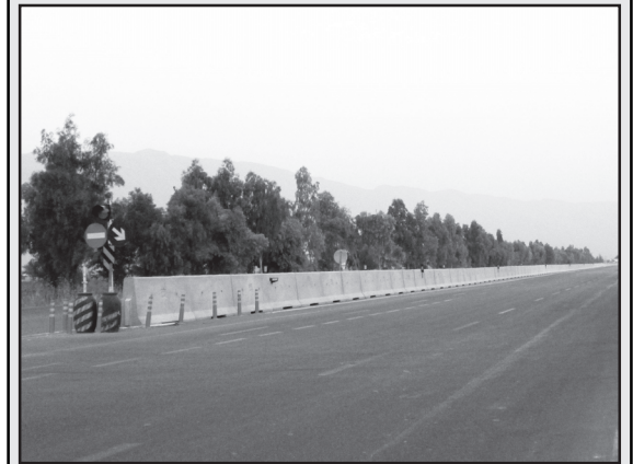
جاده جدید (کازرون - شیراز) می باشد. ورودی که عملیات چهارپایانه
