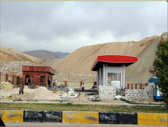
تکمیل و تجهیز جایگاه CNG بلوار مطهری
