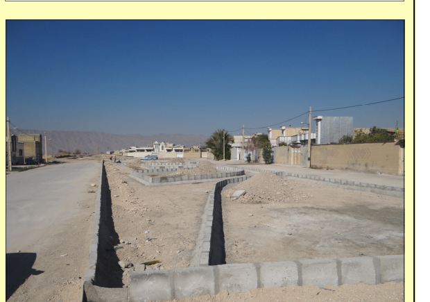
تسطیح و اجرای جدول گذاری در شهرک پردیس و احداث خیابان ۲۰ متری با اعتباری بالغ بر ۷۰۰ میلیون تومان
