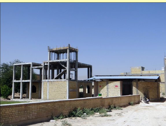
احداث نمازخانه و سرویس بهداشتی در بوستان رفیع
