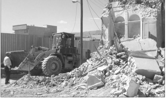
تخریب ۲ بلاک خانه مخروبه واقع در خیابان شهدای شمالی کوچه مختاری - جمعه ۹۴/۵/۹
