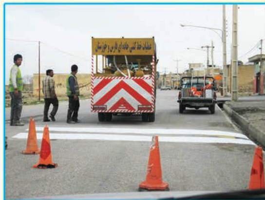
رنگ آمیزی سرویس گیرها
