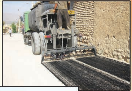
عملیات قیر پاشی
