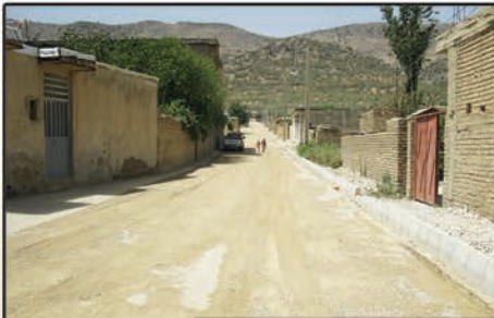
عملیات بیس ریزی
