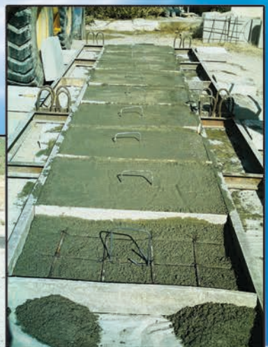
احداث کارگاه قطعات بتونی (تک لپه و دال)
