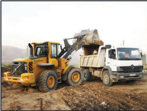
اجرای عملیات خاکبرداری توسط ماشین آلات شهرداری
