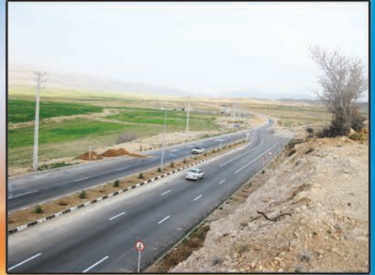
اجرای خط کشی بلوارها و میادین شهر کامفیروز
