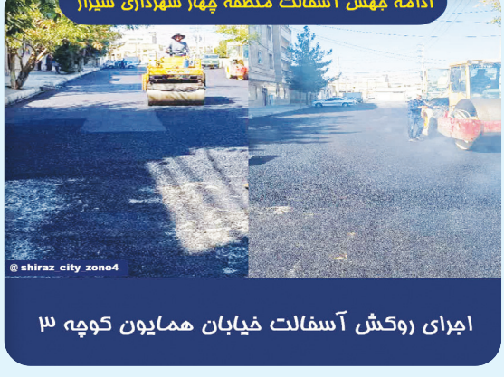
اجرای روکش آسفالت فیابان همایون کوچه ۳
